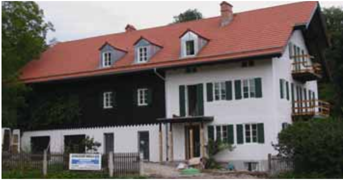
Früherer Lindl-Bauernhof: vorbildlich renoviert
