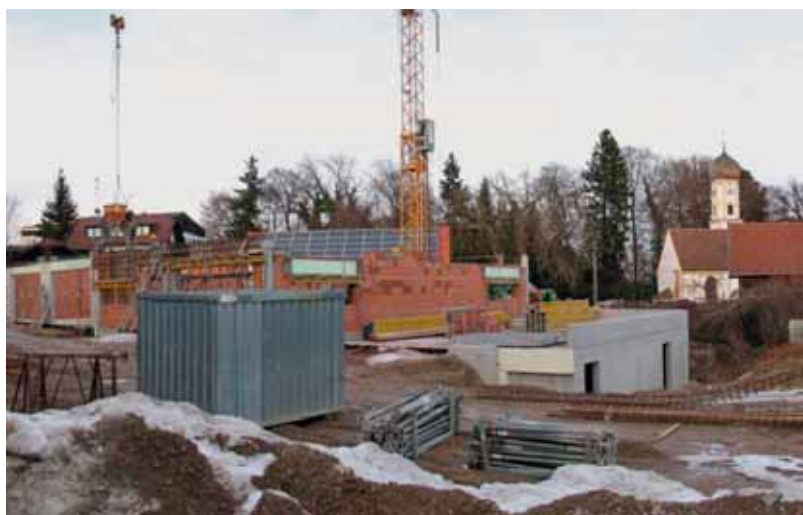
Erfolg: Baubeginn des Kinderhauses
