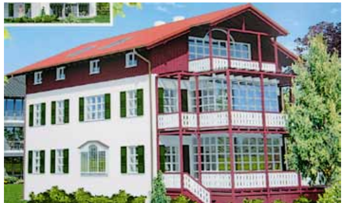
Adresse Bahnhofstraße: Renovierung mit Stil
