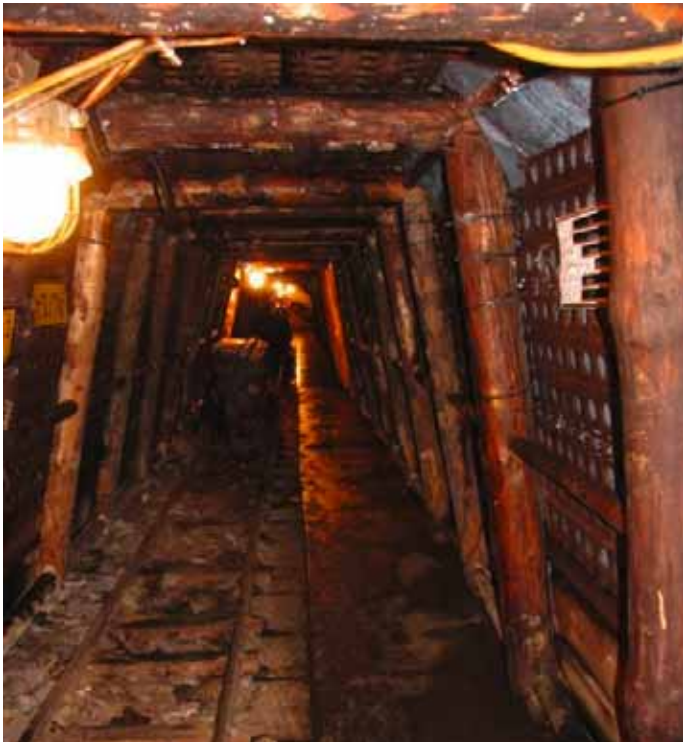
Alter Stollen im Kohlebergbau von Peißenberg
