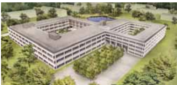
Noch ist es Baustelle, aber so soll es einmal aussehen in der General-Fellgiebel-Kaserne Computerdarstellung von Karl und Probst Architekten
